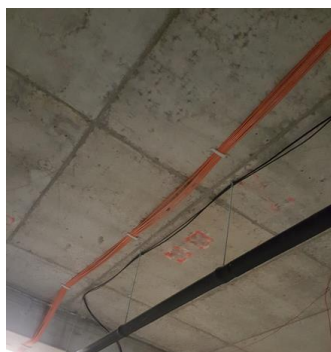
Exemple de spit au plafond dans un local terminal. Les torons de câbles doivent être proprement constitués (pas de câbles en pagaille)
