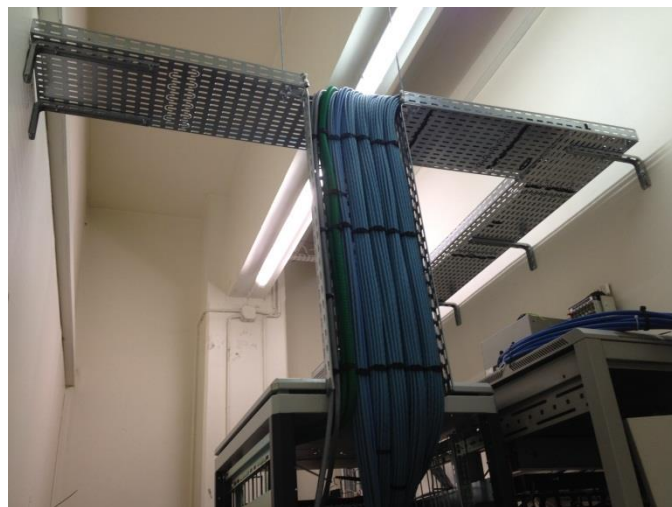
Exemple de descente d'un chemin de câbles dans une baie VDI avec des torons de câbles correctement attachés avec des bandes velcro
