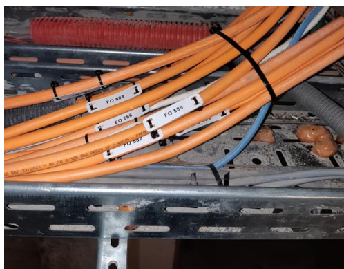
Etiquetage d'un câble optique attendu dans un chemin de câbles
