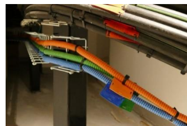
Etiquetage dans un chemin de câbles
