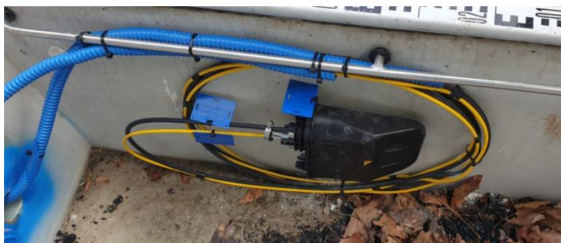
Exemple d'étiquetage attendu d'une boîte de jonction dans une chambre de tirage. Les étiquettes devront être frappées sur étiquettes en plastique pour la pérennité dans le temps en extérieur.
